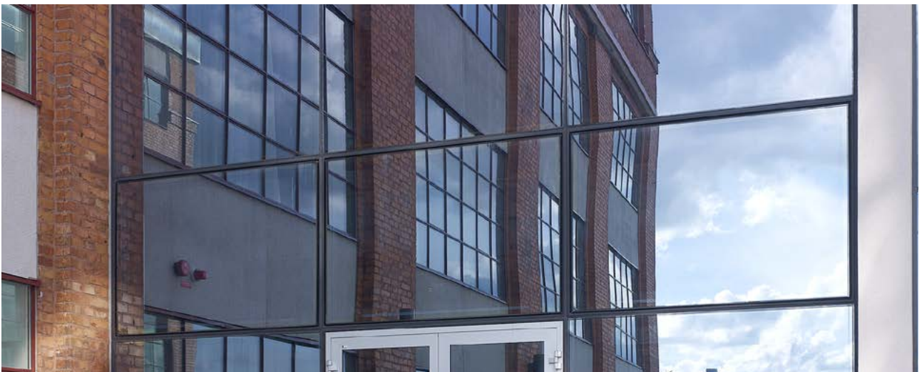
Fasadfönster 4074, stängt läge.
